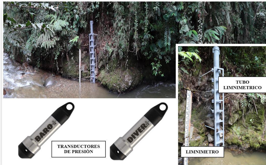
Figura 4. Estacion automática de niveles el Rasgón
